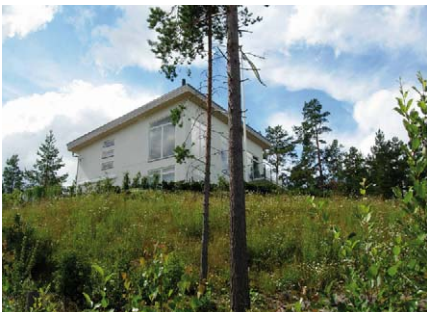
Oftast går nybygget av hus hand i hand med fällning av större mängder av träd. Här förstördes krönet nära strandslutningen.
