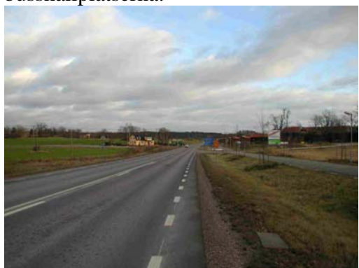
Väg 223 mot Trekanten
