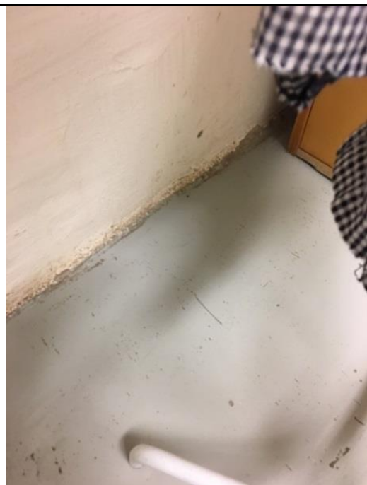
1.1 Källargolv och vägg i bageriets omklädningsrum
