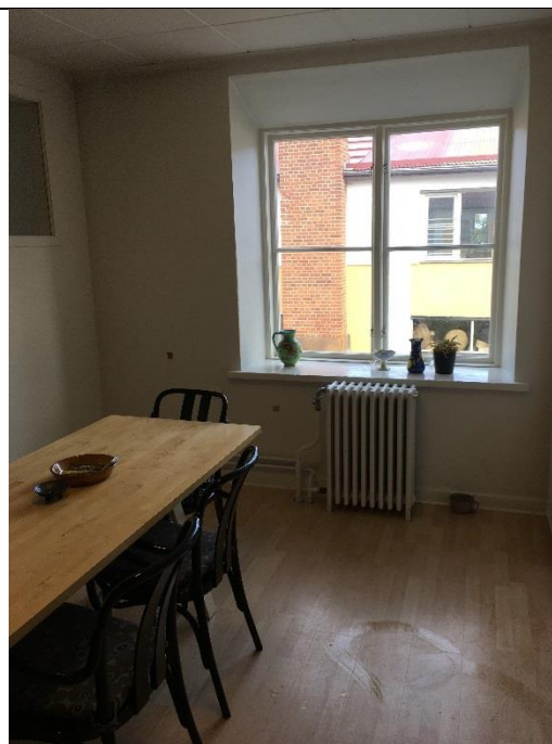
2.7 Del av provtagen vägg i pentry
