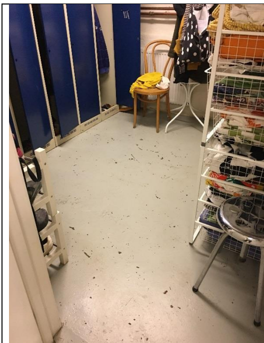
1.1 Källargolv i bageriets omklädningsrum
