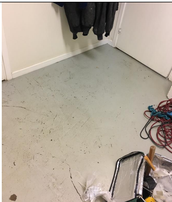
1.1 Källargolv i bageriet
