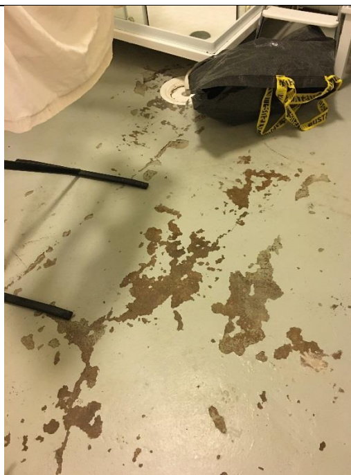
1.1 Källargolv i bageriets tvättstuga
