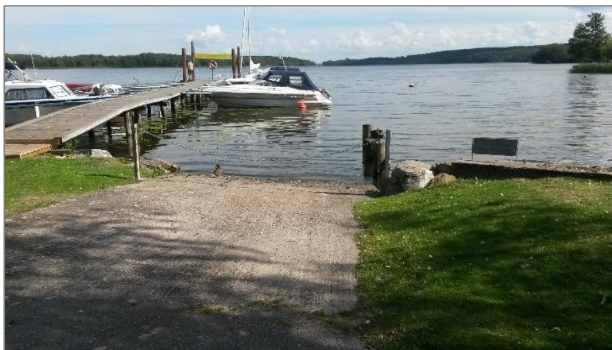
Område 4. Den befintliga kajen, iläggingsrampen och bryggan på fastigheten Vannesta 1:27.
