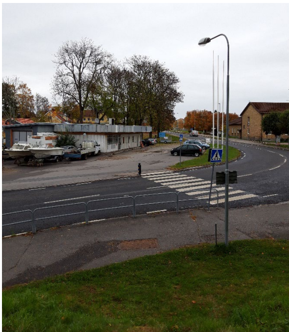
Allén av askar samt fastigheten Jören 1, Källa: Samhällsbyggnadskontoret, Google maps.
