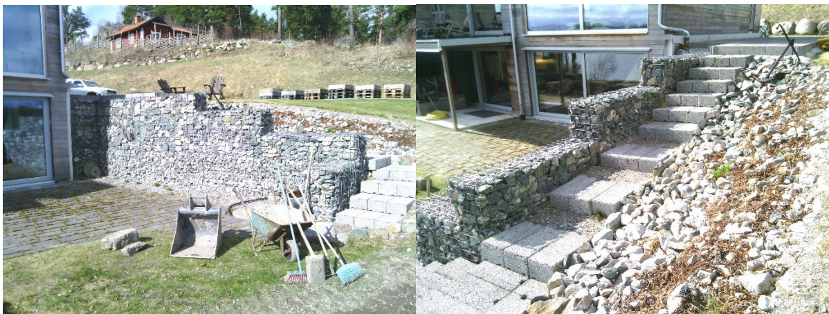
Bild 36: Gabionmur i direkt anslutning till Kråkvilan 1:20-21. Källa: Samhällsbyggnadskontoret.
