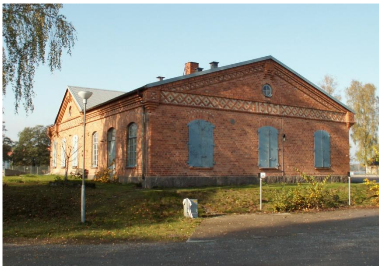
Vattenverksbyggnaden foto från sydöst
