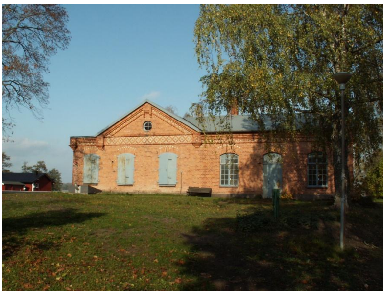
Vattenverksbyggnaden, foto från söder 2014
