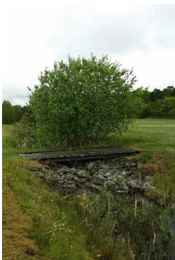
Figur 11, Exempel på uppdämning med stenröse.
