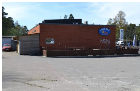
Verksamhetsbyggnaden inom området.
