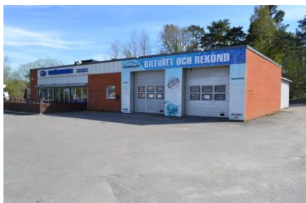
Verksamhetsbyggnad inom planområdet.
