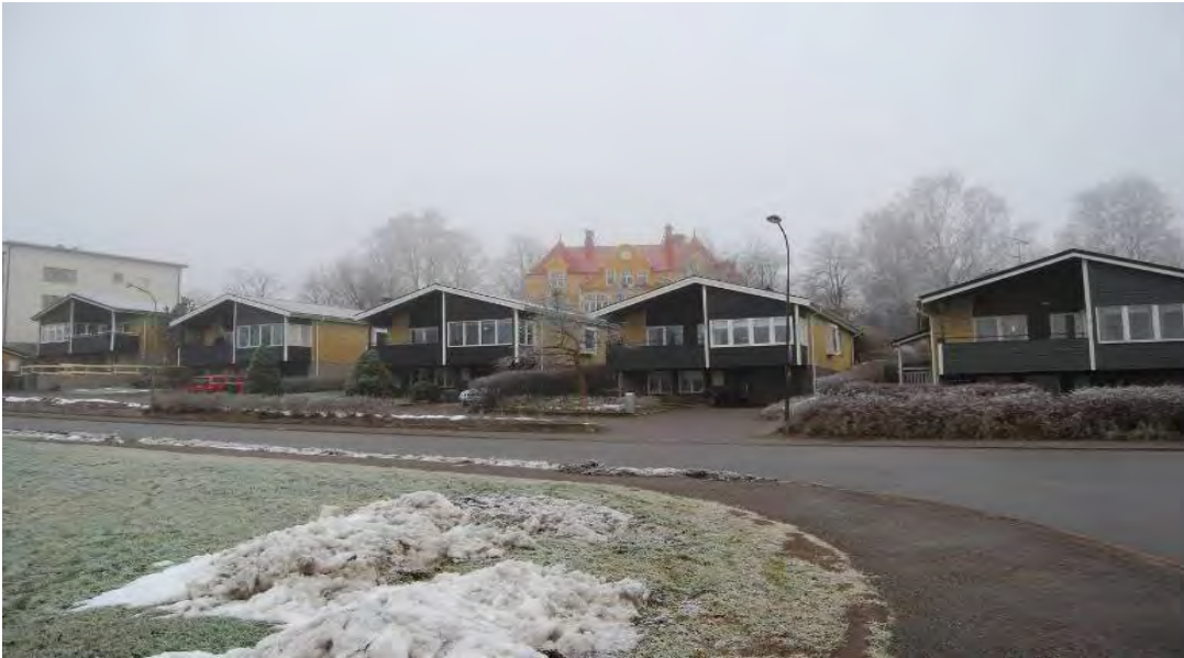
Kv Jägmästaren, Strängängs, uppförda 1967 efter ritningar av Ekroth och Hoffman.
