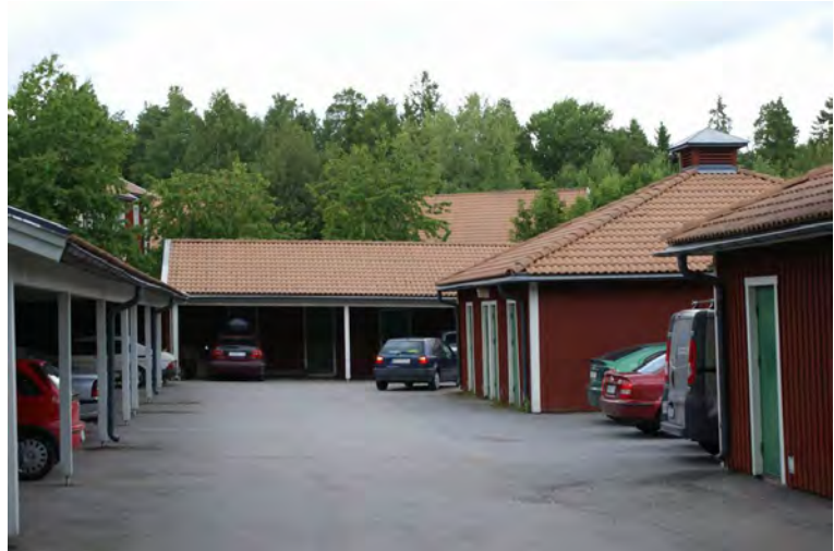
Kv Slätvaren Strängnäs. Till området hör garage och komplementbyggnader, utformade som vagnslider och ekonomibygnader till en herrgård.
