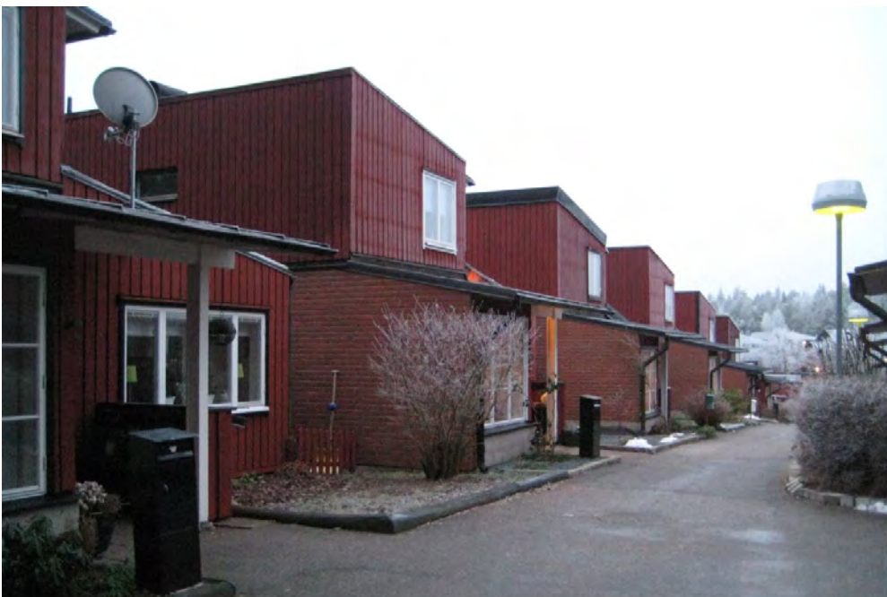
Kv Lokatten, Strängnäs, planen fastställd 1973, bygglov beviljat 1974, Fenix Ek, Arkitektgruppen. Området kallas Giraffstallarna, karaktäriseras av omväxlande höga och låga byggnadskroppar, skarpa konturer och rödfärgad panel respektive rött tegel.
