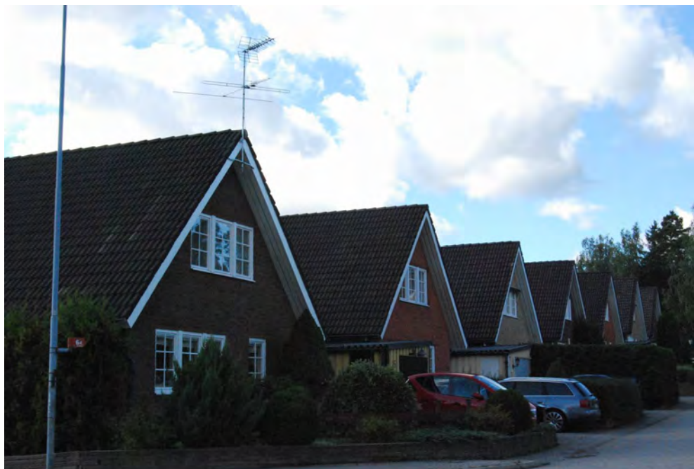
Kv Järven Strängnäs planen fastställd 1974, bygglov beviljat 1977. Arkitekt Per-Gösta Ericsson. Kedjehusområde med fasadtegel i brunt, tegelrött, gult.
