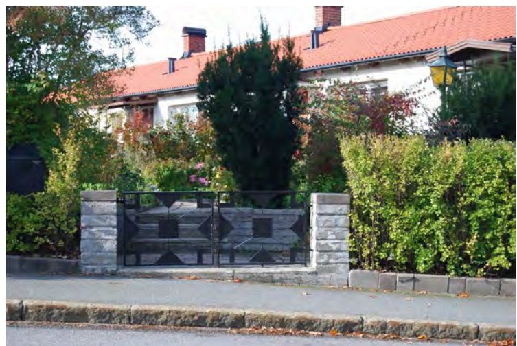
Grind med geometriskt formspråk och betongpelare.
