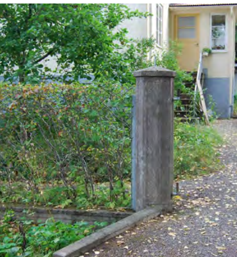
Nätstaket och formgjuten grindstolpe av betong.
