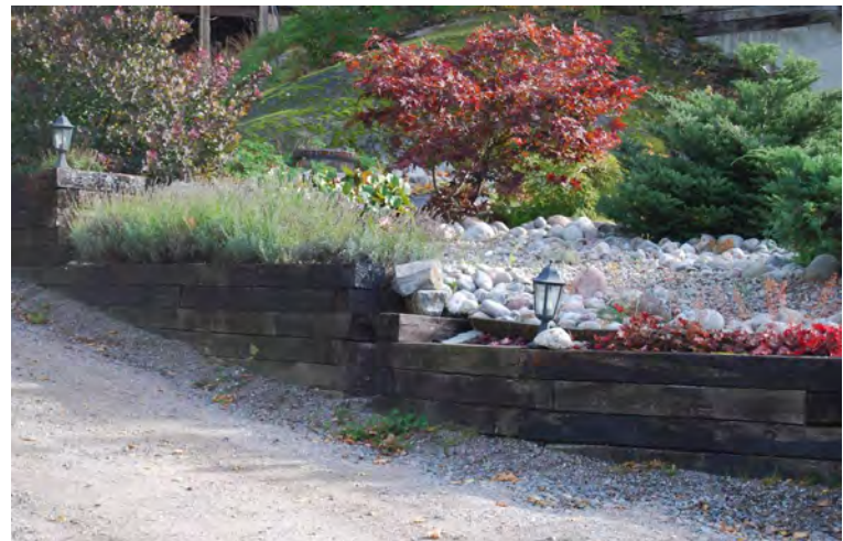
Impregnerade slipers som stödmurar är typiskt för 1970-talet.
