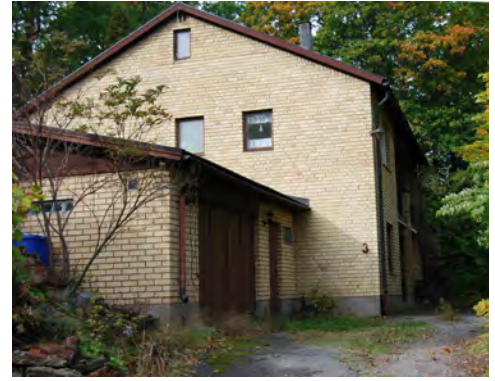
Sammanbyggt garage till tegelvilla.
